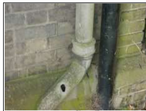
Asbestos pipe
